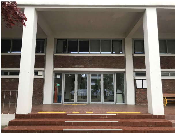
주 출입구 (열림관 출입구)
